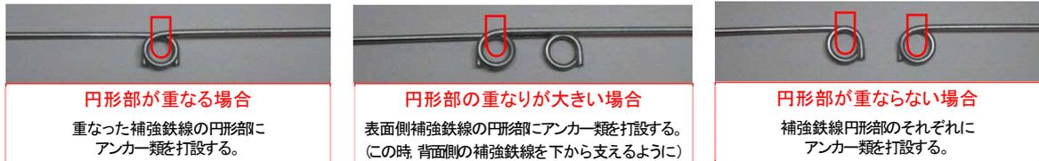
図3. 補強鉄線端部へのアンカー類の打設方法（
