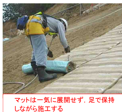
図 2. マットの展開・施工方法
