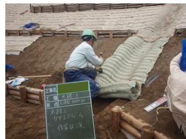
図 1. マット施工状況
