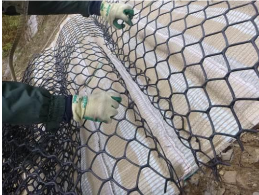
写真-14. 接続部のアンカー打設方法
