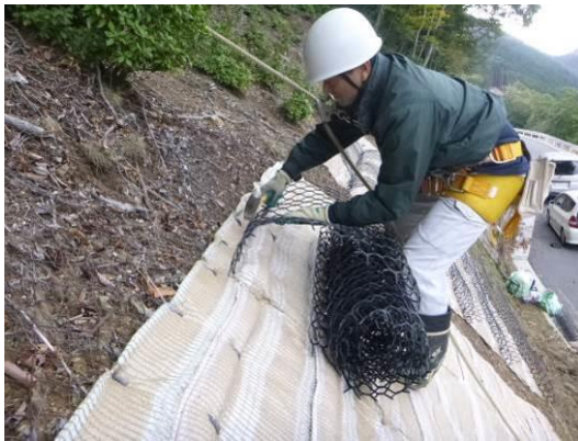
写真-4. 上端部の打設方法
