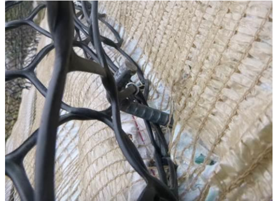
写真-14. 接続部のアンカー打設方法
