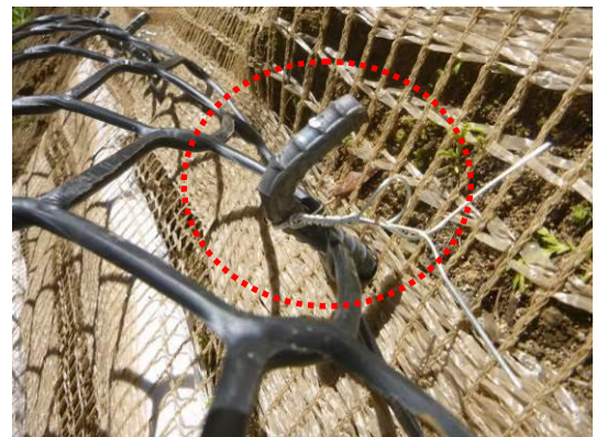
写真-7. ネットとアンカーピンの結束状況②
