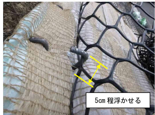
写真-5. 上端部の打設状況
