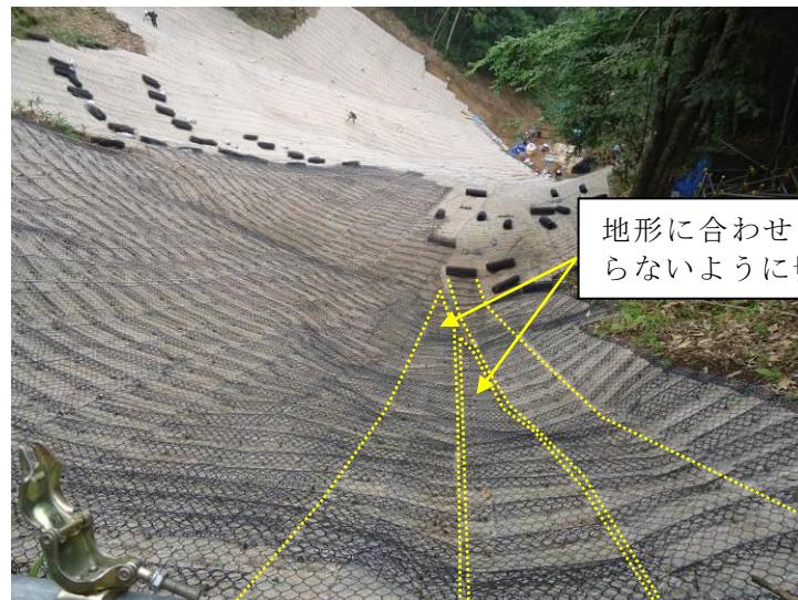
写真 17. アーチブロックを切断加工した事例
