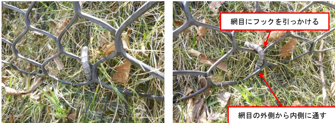
写真-16. 法尻部のアンカー打設方法
