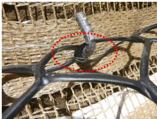
写真-6. ネットとアンカーピンの結束状況①
