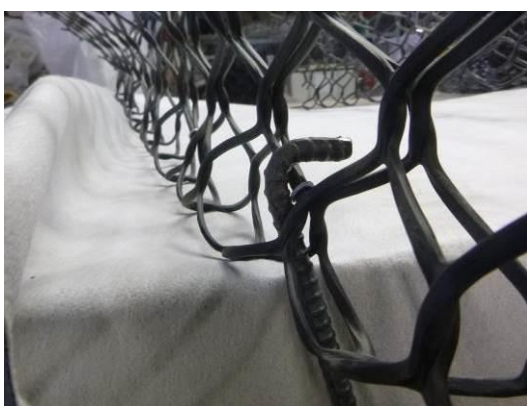
写真-12. 法面下方から見た状況
