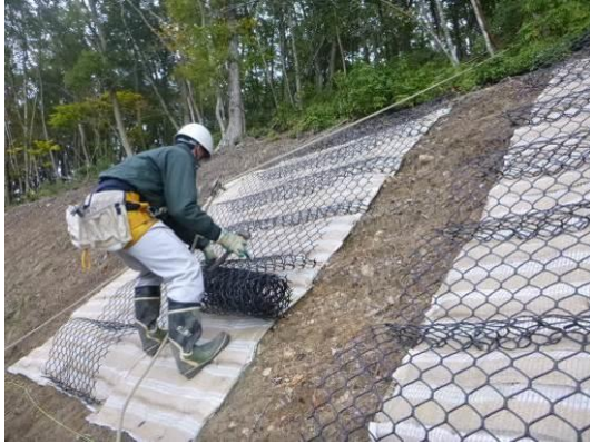
写真-3. アーチブロック展開方法
