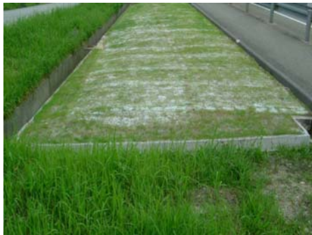
施工1ヶ月経過状況
