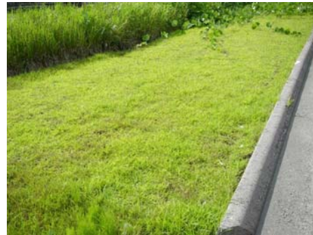
施工1年経過状況
