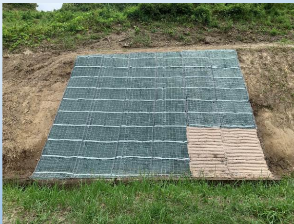
植生マット工との併用事例（試験施工）
