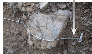
凹凸へのなじみと礫の固定
