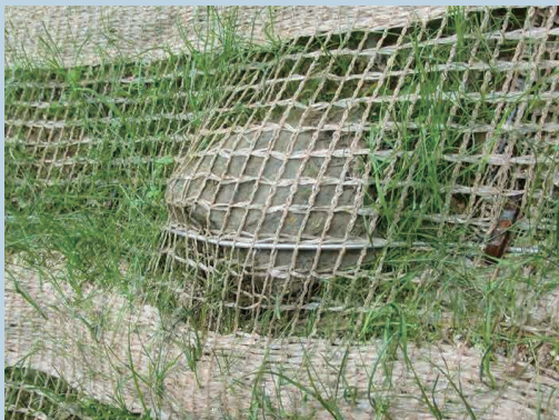
土砂や礫の移動を防止します。
