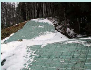
施工直後（積雪を確認）
