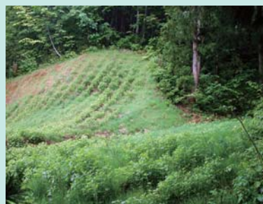
施工後 1 年 5 ヶ月
