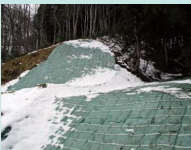
施工直後 (積雪を確認)
