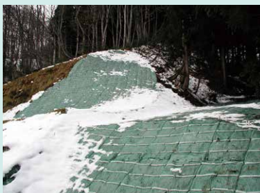
施工直後（積雪を確認）
