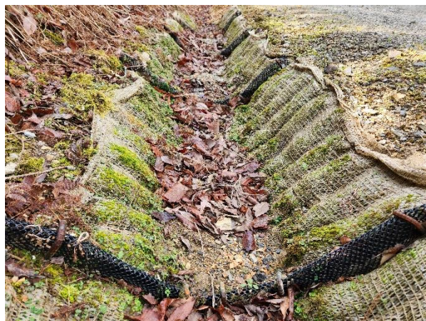
施工後 1 年 6 ヶ月 侵食防止と景観性向上を両立
