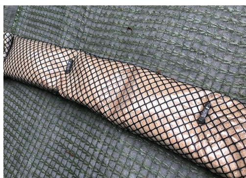
流速軽減袋 間伐材を充填しています
