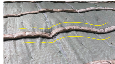
凹凸法面での設置状況
