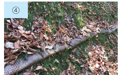
④ 流速軽減袋への落葉堆積状況 (5ヶ月後) 耐侵食性の向上が期待できます
