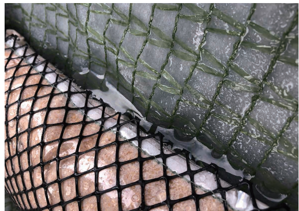
流速軽減袋の表面水堰き止め状況
