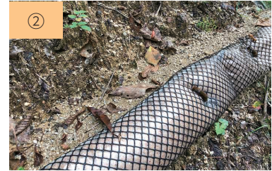
② 流速軽減袋への土砂堆積状況
