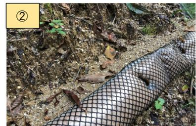
流速軽減袋への土砂堆積状況
