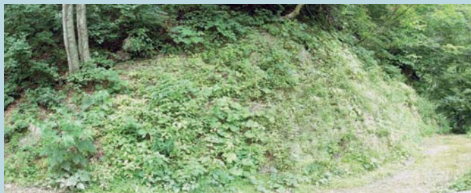
施工後1年9ヶ月
