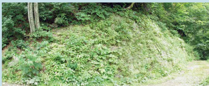
施工後1年9ヶ月
