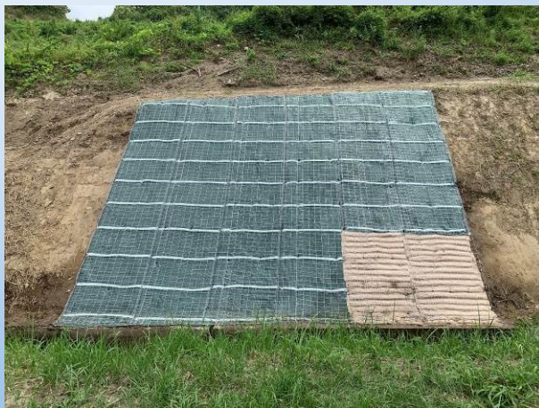
植生マット工との併用事例（試験施工）
