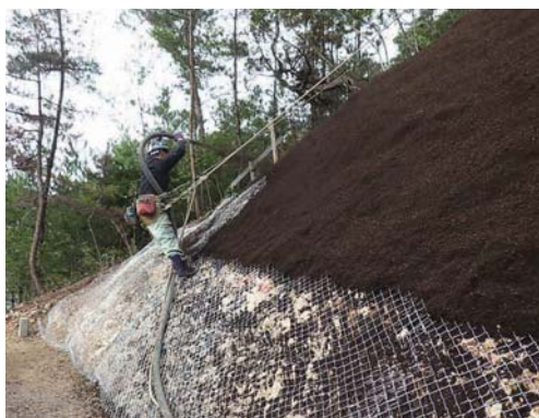
植生基材吹付工
