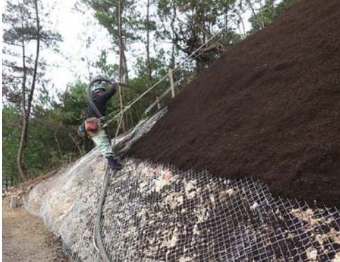
植生基材吹付工
