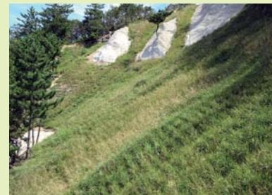
施工後1年2ヶ月
