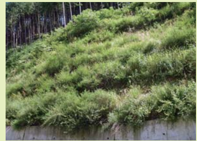
施工後3年5ヶ月
