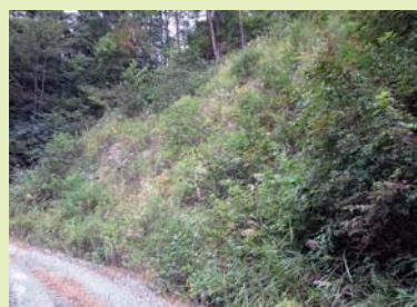
施工後5年3ヶ月
