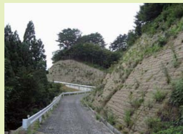
施工後 1 年 1 ヶ月
