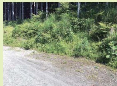
施工後2年5ヶ月
