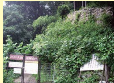
施工後 1 年 4 ヶ月
