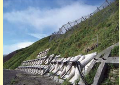
施工後 5 年 8 ヶ月
