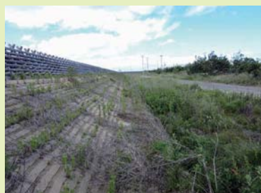
施工後1年3ヶ月
