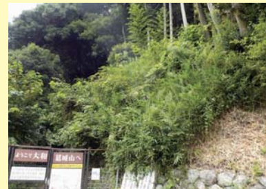
施工後 3 年 5 ヶ月
