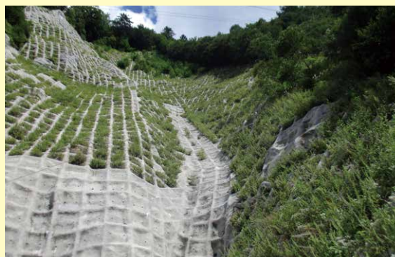
施工後 3 年 1 ヶ月
