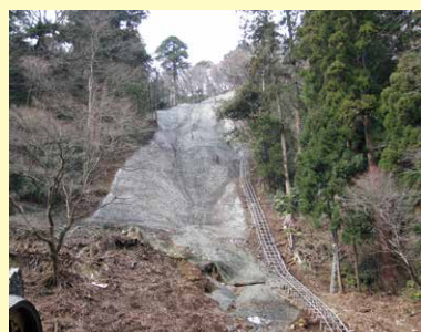
連続繊維複合補強工 施工直後
