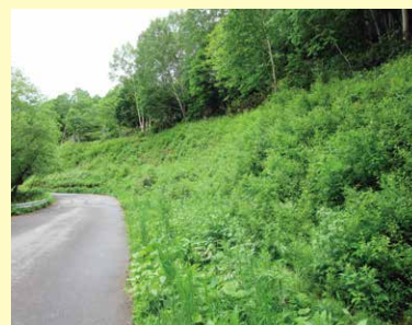
施工後 2 年 8 ヶ月
