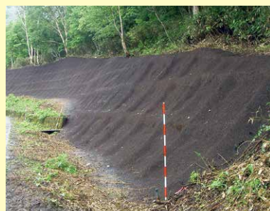
補強土植生法砕工 施工直後
