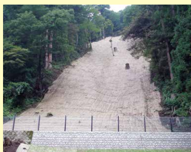
植生マット 施工直後
