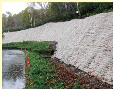
植生マット 施工直後
