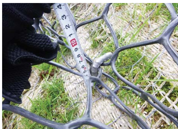
アンカー打設状況
