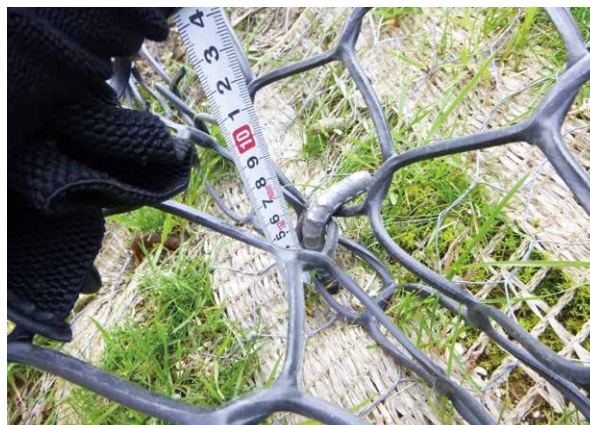
アンカー打設状況
