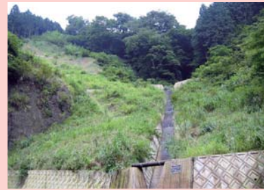
施工後 1 年 6 ヶ月
