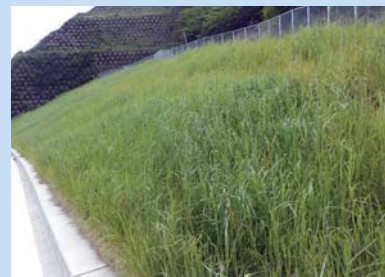
施工後 1 年 4 ヶ月
