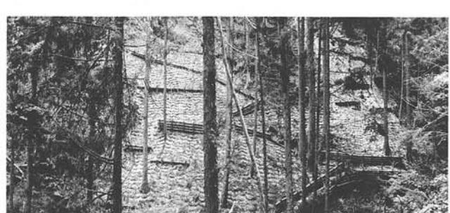
写真3. 施工後の植生推移 (誘導型マット①, 左: 5ヶ月後, 右: 2年5ヶ月後)
