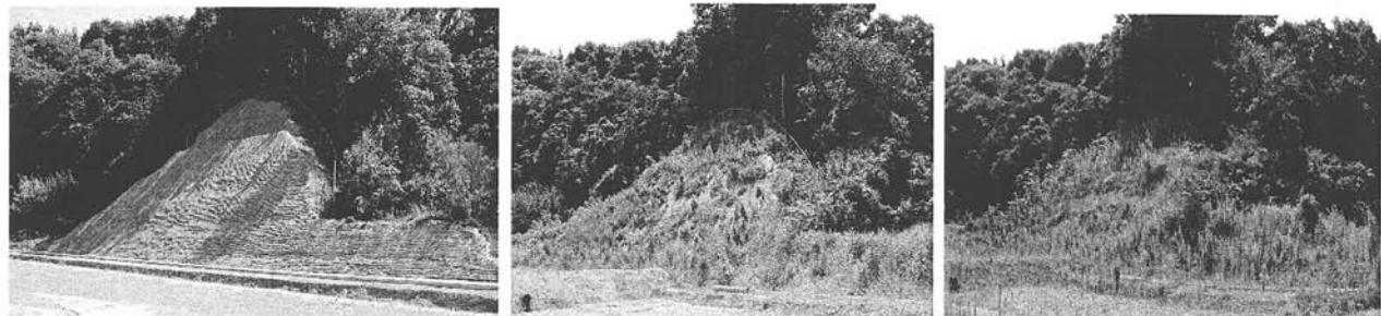
写真4. 施工後の植生推移（誘導型マット②, 左: 3ヶ月後, 中: 6ヶ月後, 右: 1年8ヶ月後）
