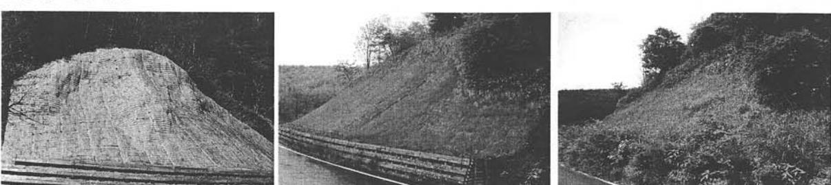
写真1. 施工後の植生推移(厚層マットの代表法面のみ、左:1ヶ月後、中:1年後、右:9年4ヶ月)
