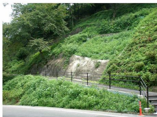
施工後3ヶ月経過状況
