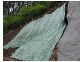
施工途中（平成 21 年 6 月調査）
