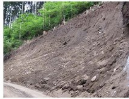
施工前（平成 21 年 5 月調査）
