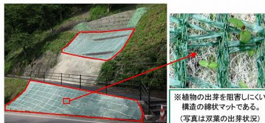
施工後1ヶ月経過状況
