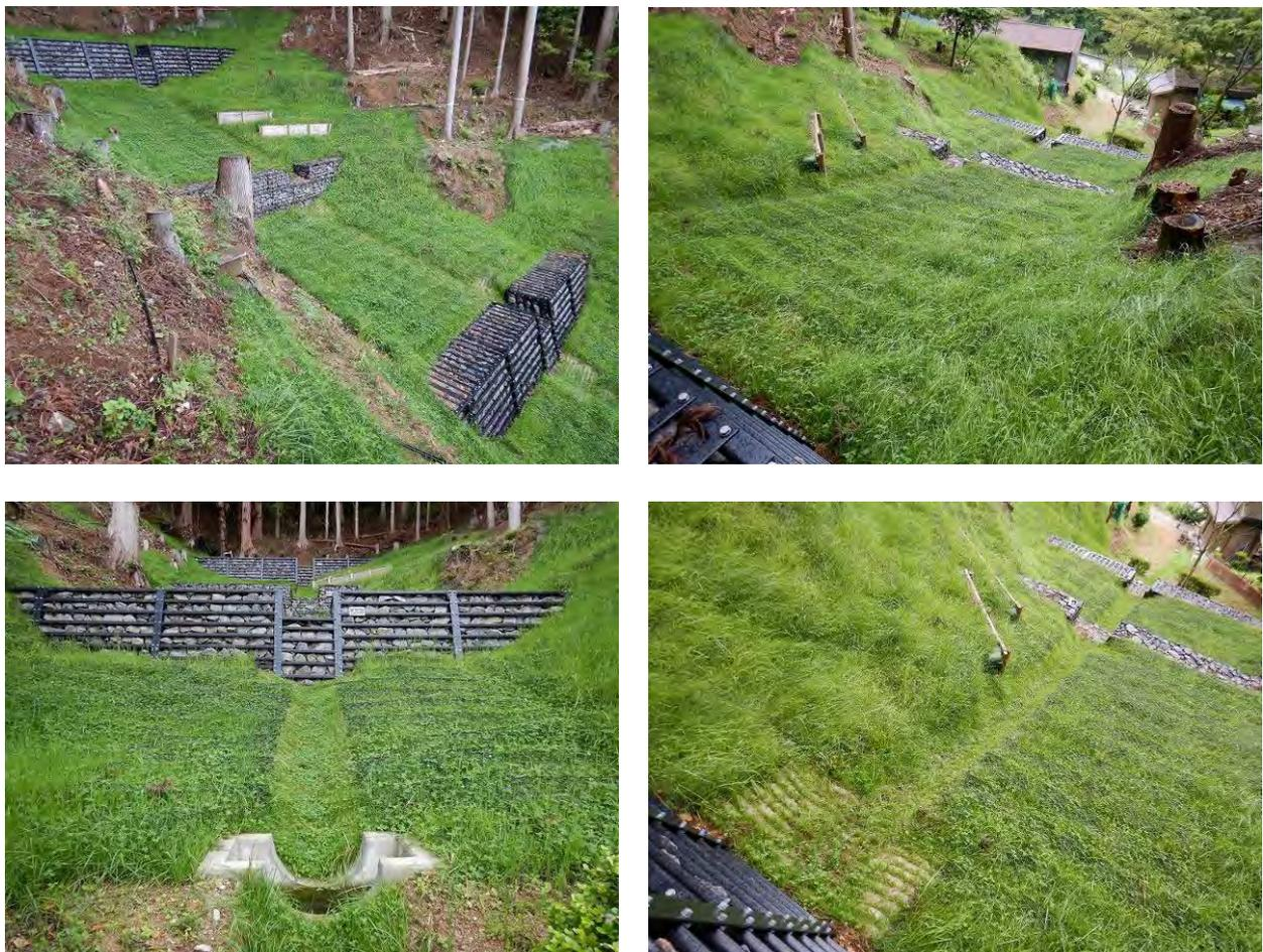
アーチブロック施工箇所は植生が保護され、植物が伸長している。保護されていない水路部は食害を受けている。
